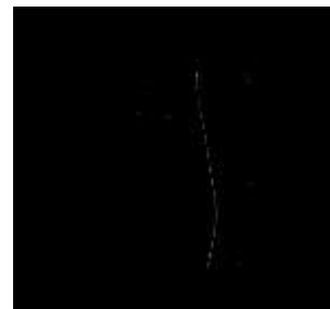
Рис. 4. Обработанное изображение плитки с дефектом в виде неглубокой трещины
